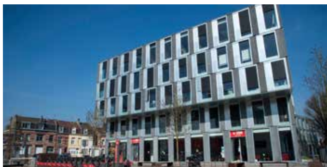
L'immeuble Le Bretagne, à EuraTechnologies, propriété de la Foncière de l'Érable.
